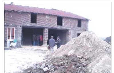
Les aides versées dans le cadre du PIG permettent par exemple de créer de nouveaux logements
