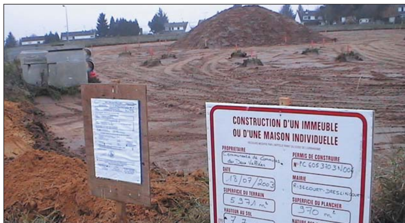
Les travaux de terrassement ont débuté au début du mois de décembre
